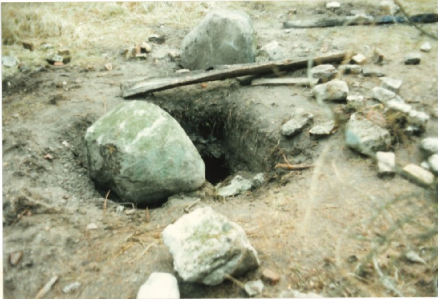
Einstiegsloch in den Bunker 1995
